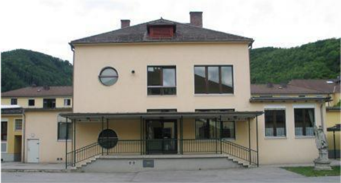
Fassade vor Projektbeginn
