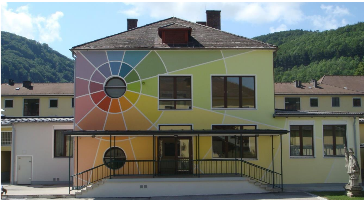
Fassade nach Abschluss des Projektes
