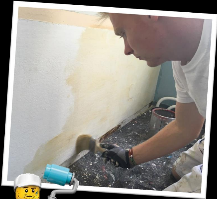
Entfernen der alten Farbschichten
